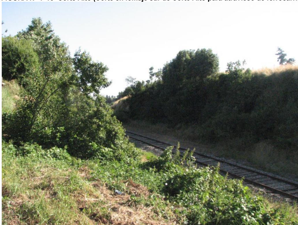
Fotografía de INFRACON S.A.
