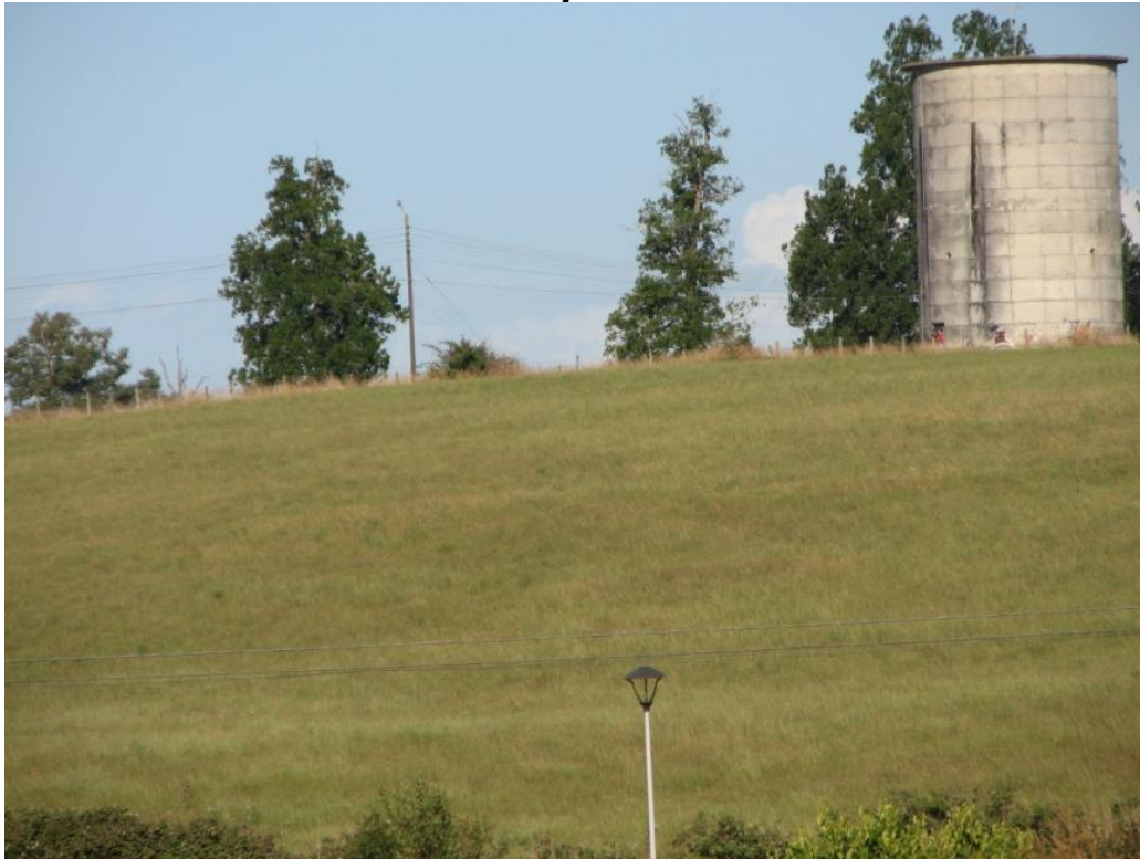
Fotografía de INFRACON S.A.
