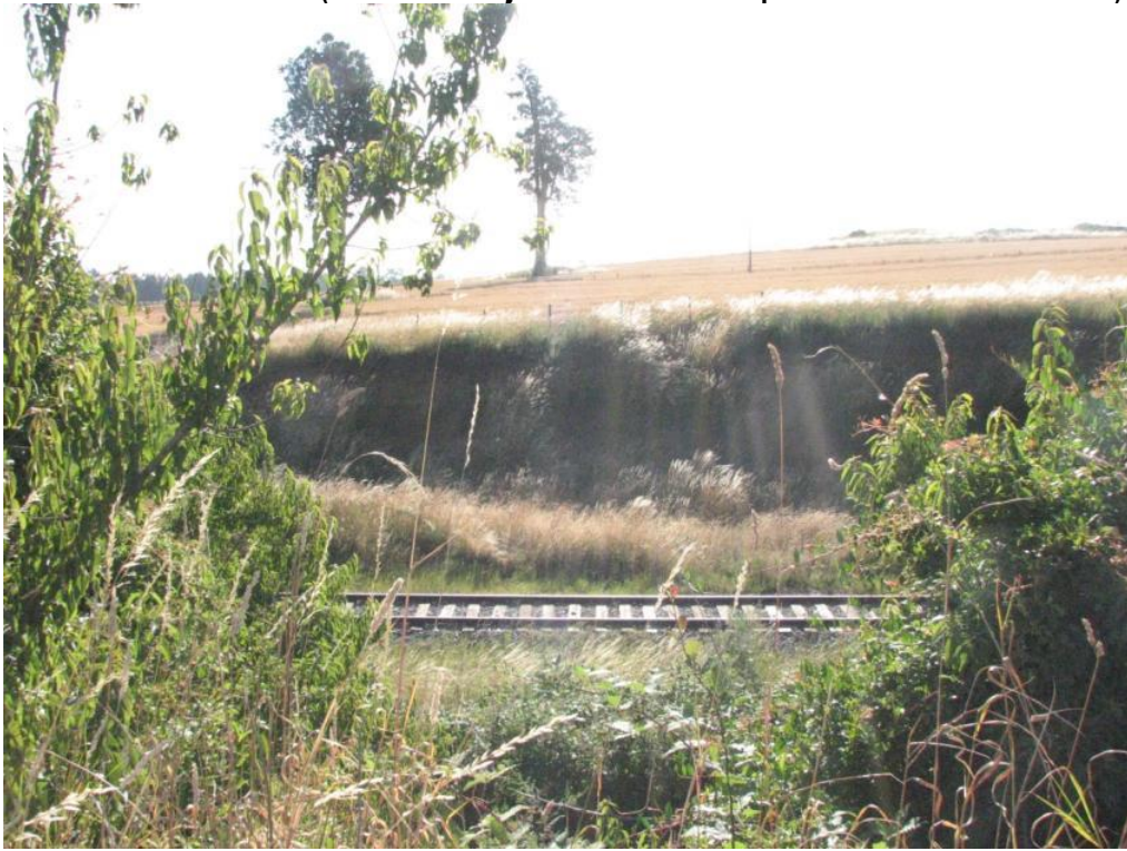
Fotografía de INFRACON S.A.
