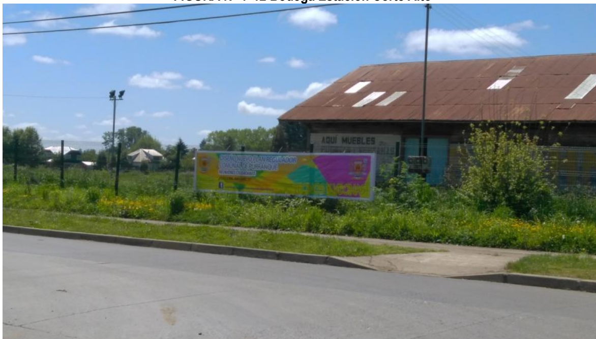
Fotografía de INFRACON S.A.
