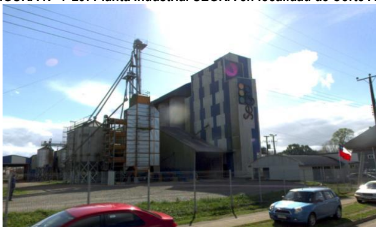
FIGURA N° 7-29: Planta Industrial SEGRA en localidad de Corte Alto
