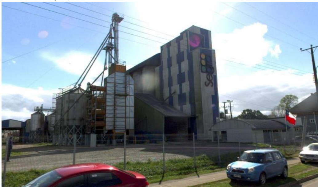
FIGURA N° 3-24: Ejemplo de construcción industrial ubicada en Corte Alto: Planta Industrial SEGRA
