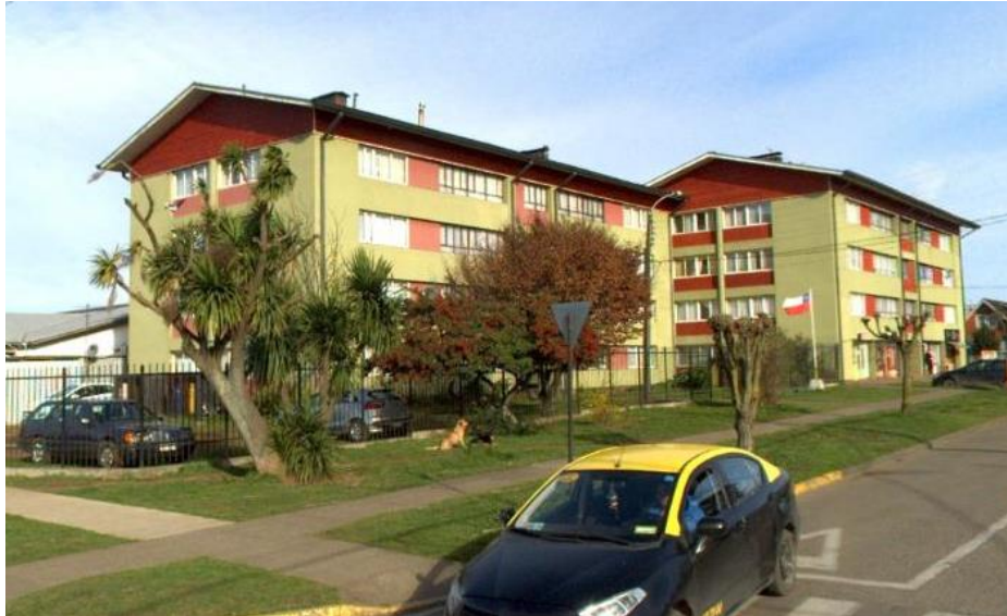
FIGURA N° 3-14: Conjunto de viviendas colectivas de 4 pisos (Santo Domingo con Tomás Burgos)
