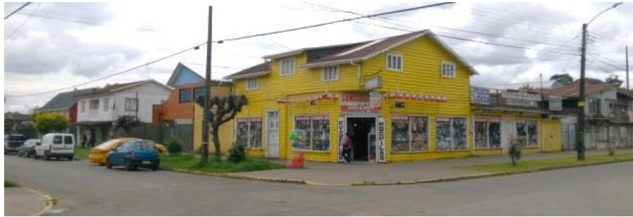
FIGURA N° 3-10: Ejemplo de casas presentes en el damero fundacional: 2 y 3 pisos
