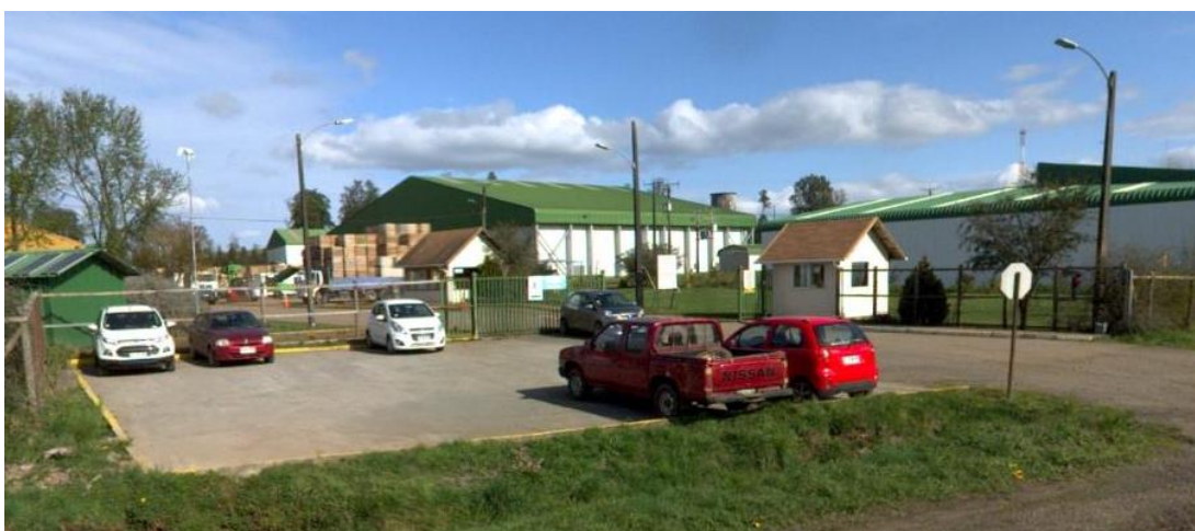
FIGURA N° 3-25: Ejemplo de construcción industrial ubicada en Corte Alto: Agrícola El Parque
