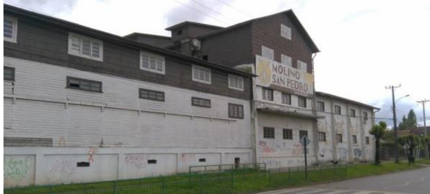
FIGURA N° 3-18: Ejemplo de edificación industrial ubicada en Purranque: Molino San Pedro
